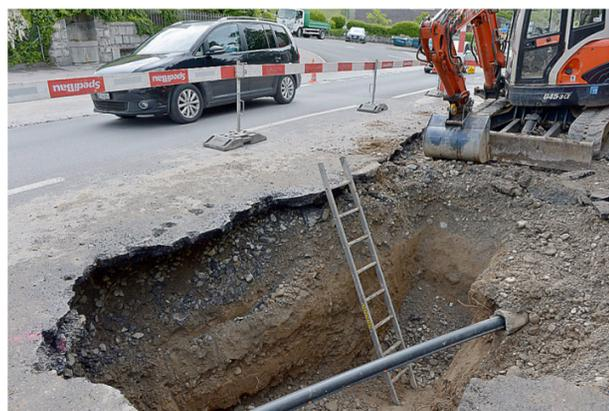
Vorläufig nur noch einspurig befahrbar: Im Bereich der Hünibach-Brücke wurde die Staatsstrasse nach einem Rohrbruch unterspült. *Patrick Spahni*
